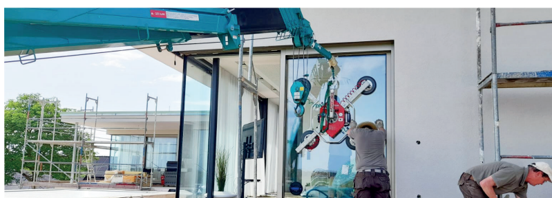
Durch unterschiedliche Anordnung der Saugteller kann der Vakuumsauger optimal an unterschiedliche Scheibengrößen angepasst werden
