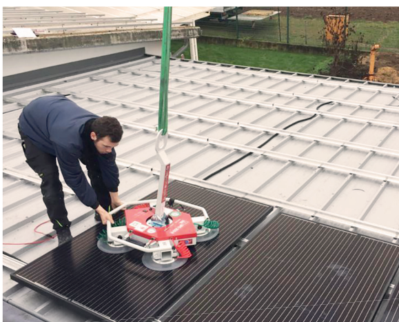
Der UPG 350 kann Elemente wie Solarpaneele, furniertes Holz, Metall- und Kunststoffplatten und vieles mehr ansaugen
